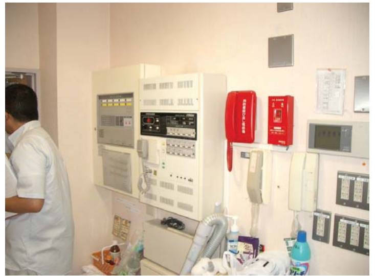
大久保学園(入所施設内部)
