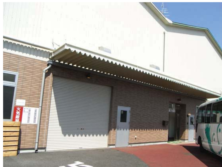
船橋工房第2分場(授産施設外観)
