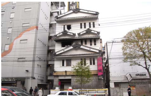
火災発生後の「エレガントバス江戸城」の外観
